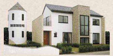
無添加住宅 深谷モデルハウス外観
