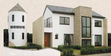
無添加住宅 深谷モデルハウス外観
