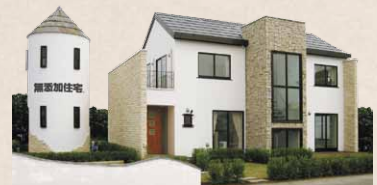
無添加住宅 深谷モデルハウス外観
