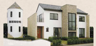
無添加住宅 深谷モデルハウス外観
